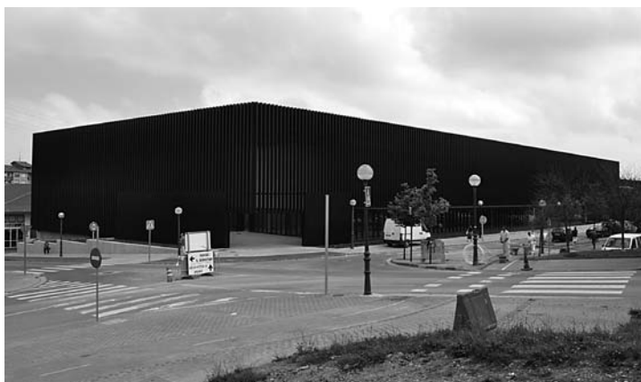
Fig. 1. Vista general del edificio
