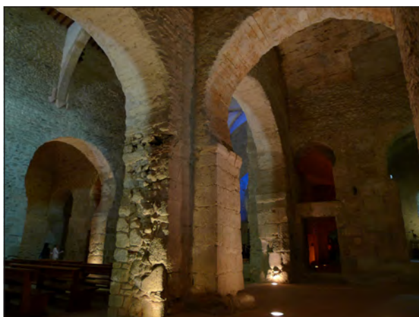
Fig.8. Interior de Saint-Michel de Cuxa. Vista desde nave lateral derecha, la intersección con el transepto y el acceso al pasillo lateral derecho del ábside (Foto G. Ripoll).
