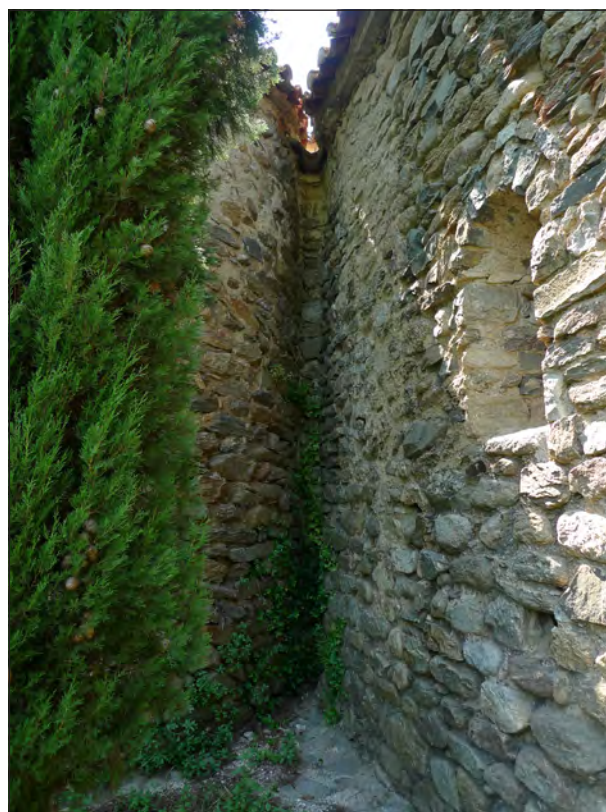
Fig. 9. Exterior de Saint-Michel de Cuxa. Vista de la primera absidiola derecha y el adose del muro del pasillo derecho del ábside al transepto. Se observan los aparejos similares en ambas estructuras (Foto G. Ripoll).
